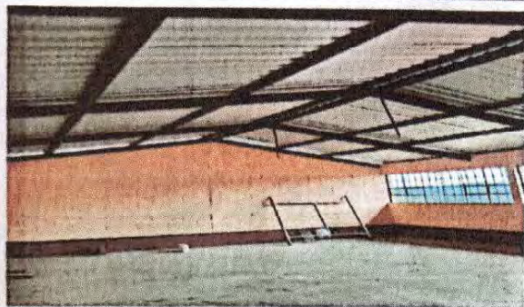
Foto1: reparación de sistema eléctrico
