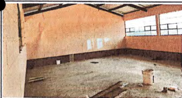
Foto 5: pintura en muros exteriores e interiores
